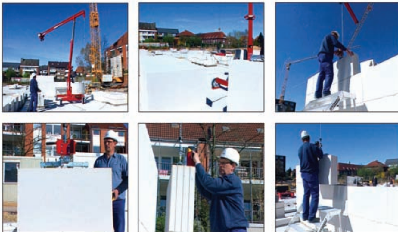
Zdění pomocí minijeřábu – KS-QUADRO 2 ks (0,5 m 2 ) najednou
