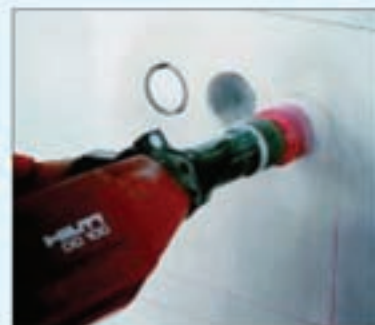
Postup při provádění elektroinstalace kanály KS-QUADRO E
