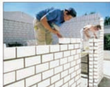
Vyrovnávací vrstva běžnou zdicí maltou.
