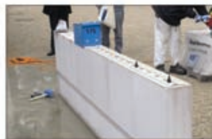
Nanášení tenkovrstvé malty maltovacími sáněmi.
